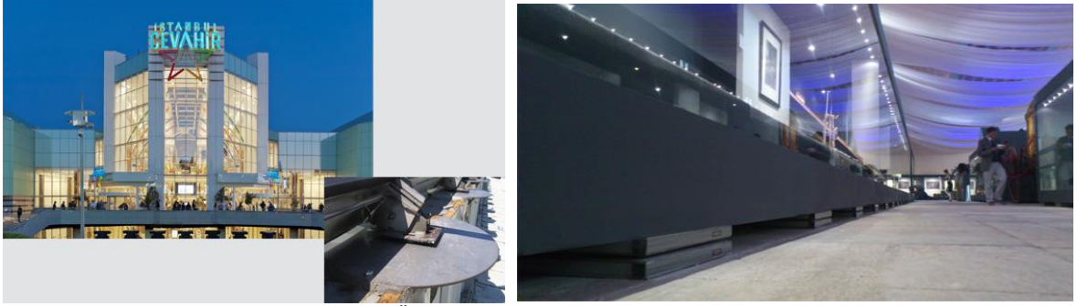
Şekil 6 ve 7. Özel tip sismik izolatör kullanım örnekleri
