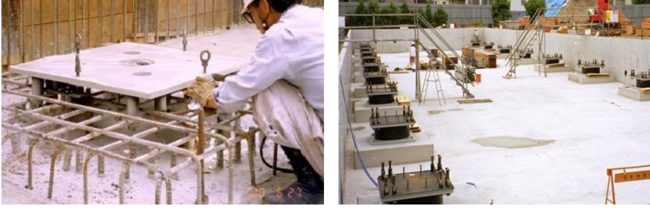
Şekil 2. Deprem yalıtım sistemi montajı
