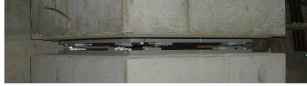
Şekil 5. Bir kolon ortasında sürtünme esaslı sismik izolatör
