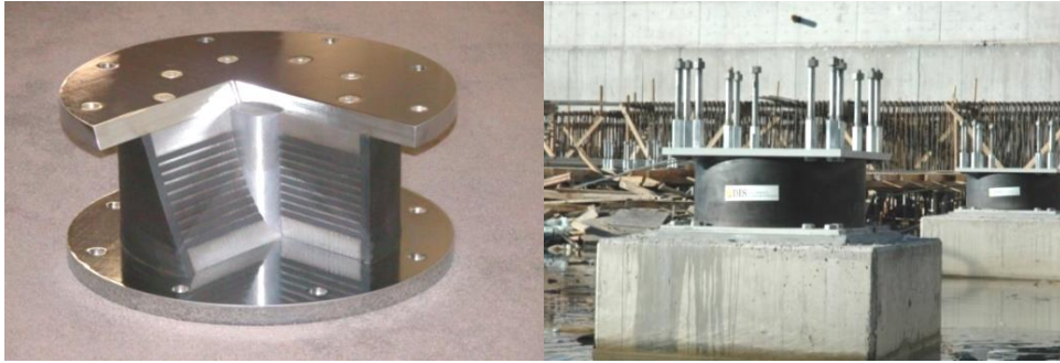
Şekil 5. Erzurum Hastanesinde Sismik İzolatör (LR) Uygulaması, 2007 (Constantinou, 2013)
