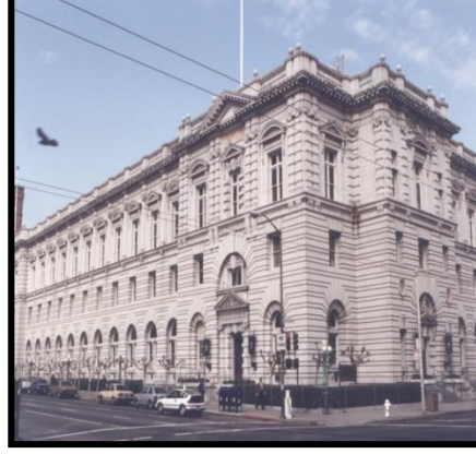
Şekil 12. Loma Prieta depreminde hasar görmüş ve güçlendirilmiş mahkeme binası, 1989
