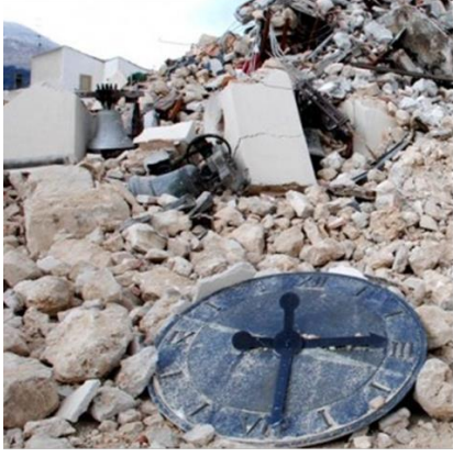
Şekil 11. İtalya depreminde Santa Maria kilisesinin hasarı, 2009
