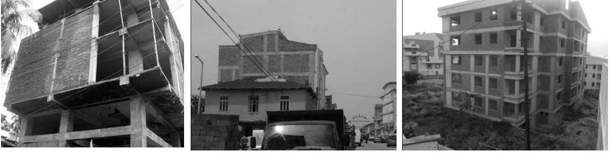
Şekil 2. Düşey süreksizliğe sahip bazı betonarme binalar
