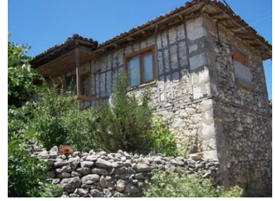
Taş yığma yapı
