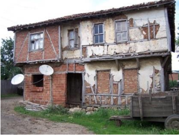
Ahşap iskelet yapı
