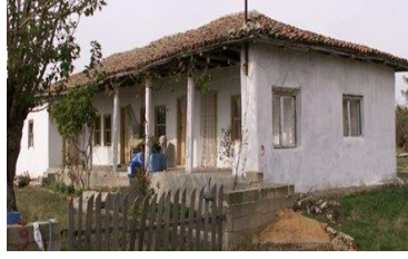
Kerpiç yığma yapı
