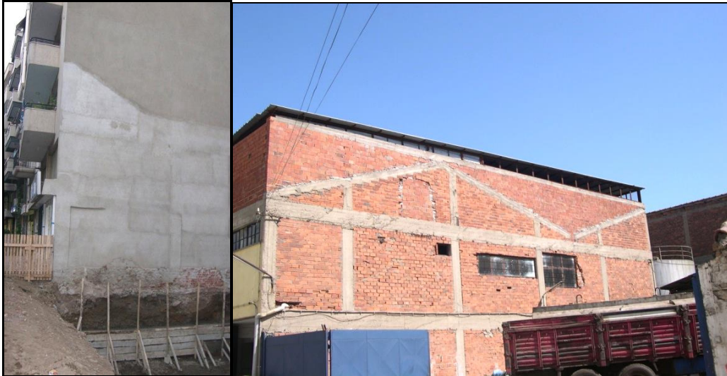
Şekil 3. İzmir Şemikler'de temsiz 5 katlı bina (solda), Çinerli'da çatının sökülmesiyle kazanılan kaçak daire (sağda) (Anonim, 2009)
